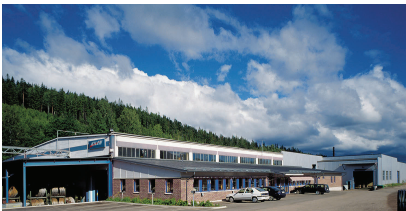
Завод Kilen в Лейшефорсе, Швеция.
